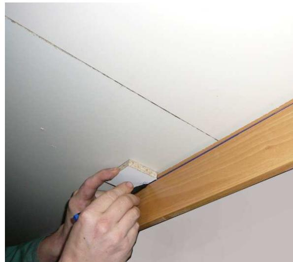
Horizontalna maska pri omari s klasičnimi vrati je vedno v dekorju zaključnih stranic. V podjetju se pripravi pas iverala v ustreznem dekorju, ki se pri montaži dimenjsko ustrezeno priežemo glede na režo med korpusom in stropom. Z masko se zapre prostor med vrhom korpusa in stropom, po celotni dolžini omare. Če je omara večje dolžine, se maska izdela iz dveh ali več smiselno razdeljenih pasov.
